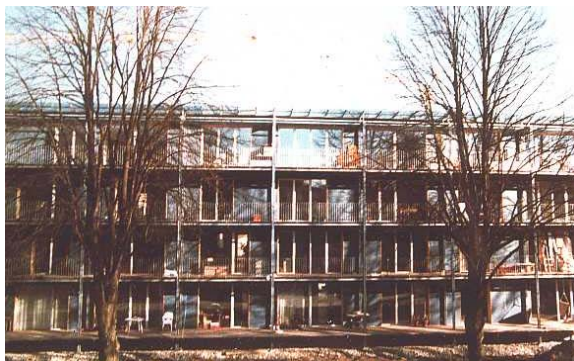
Facciata Sud dell'edificio a Friburgo
