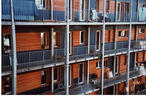
Facciata Nord dell'edificio a Friburgo
