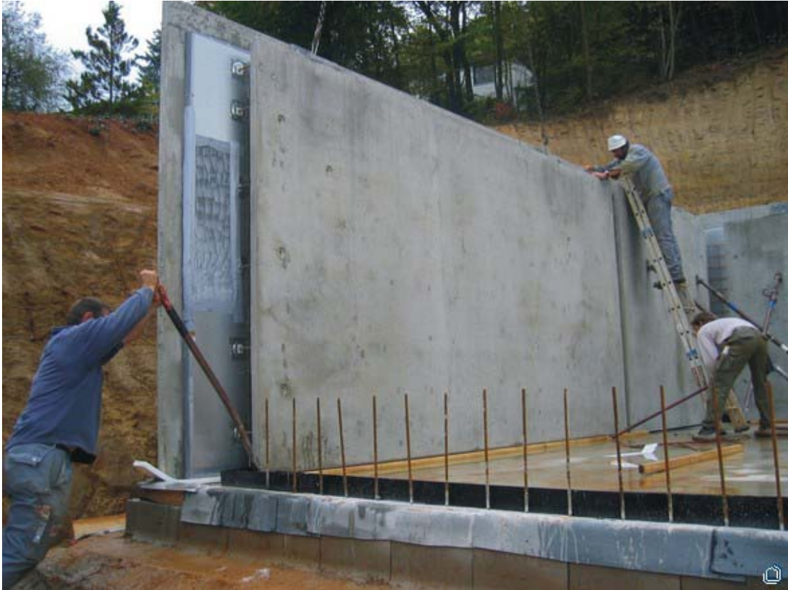
Elemento sandwich in calcestruzzo con isolamento termico sottovuoto integrato
