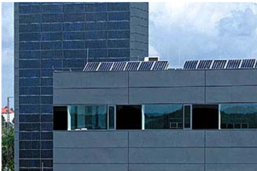
Moduli fotovoltaici sulla facciata della torre e su tetto dell'edificio
