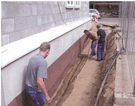
Posa dello scambiatore interrato ad acqua all'esterno dell'isolamento termico perimetrale
