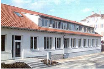
Veduta dell'edificio risanato
