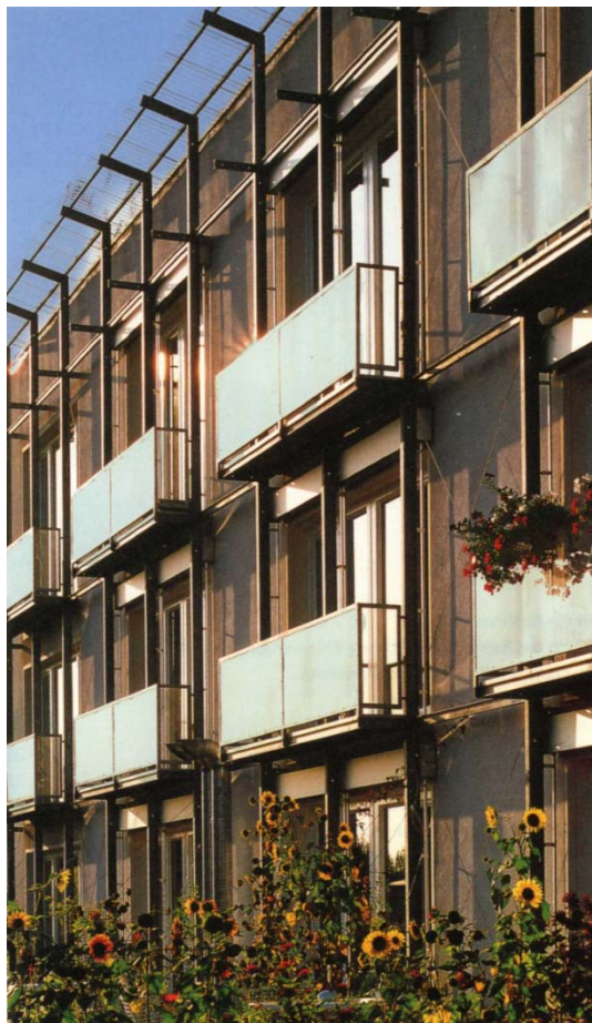
Darmstadt-Kranichstein - Edificio passivo - Facciata Sud
