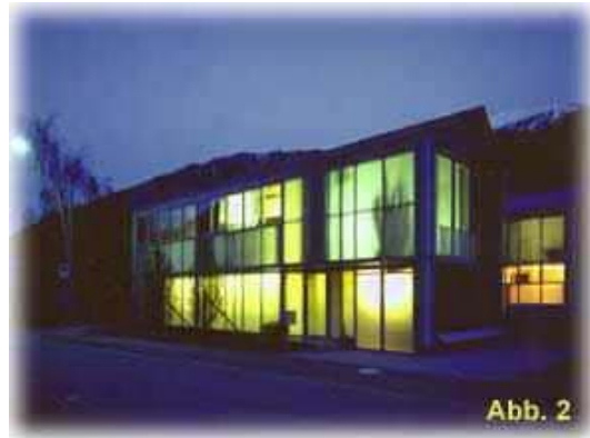
La facciata luminosa durante la notte
