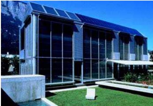
La facciata traslucida con le finestre in alt
