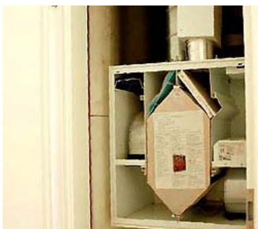
Aggregato compatto di ventilazione che recupera il calore dall'aria in uscita
