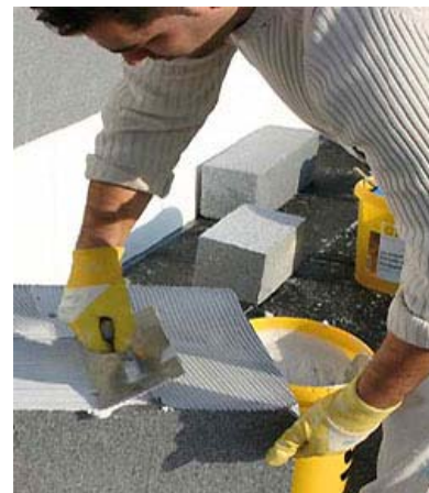
Posa dei blocchi termoisolanti
