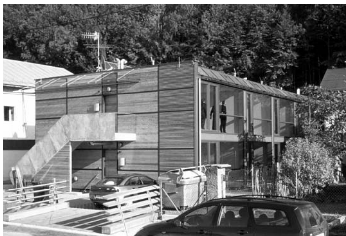
Gnigl - L'edificio passivo - Veduta da Sud
