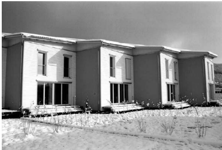
Nebikon (CH) – Facciata Sud
