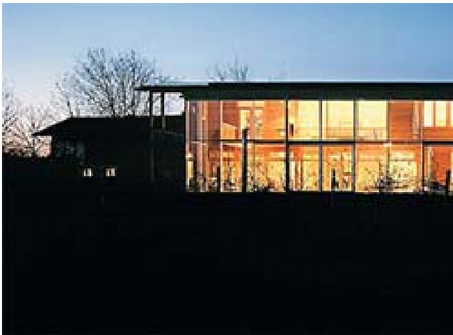
La facciata sud di sera
