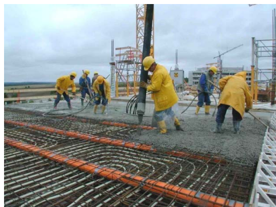
Solaio in costruzione
