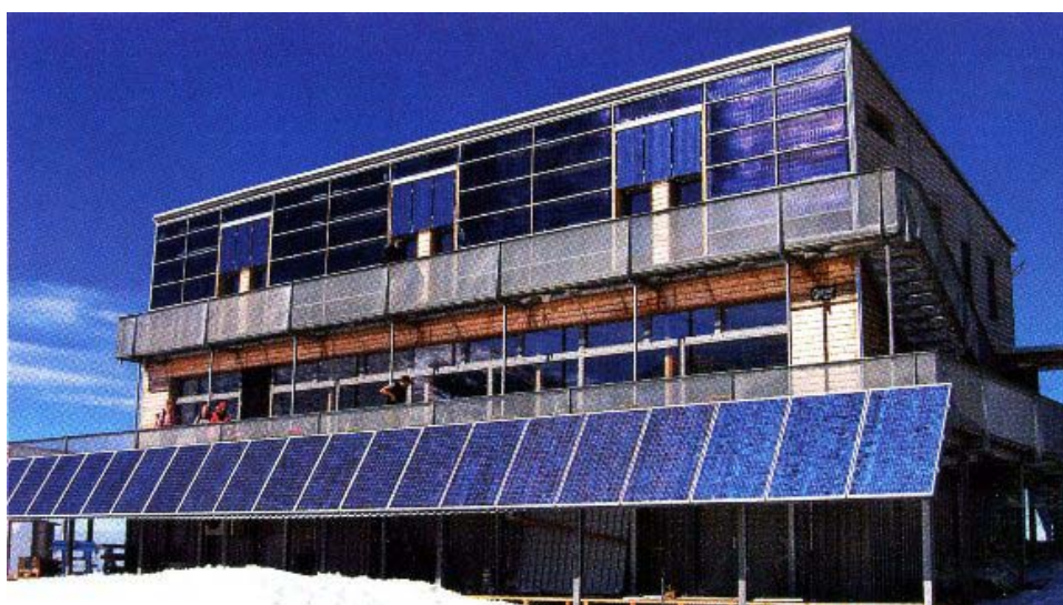
La baita Schiestlhaus (Stiria) è totalmente autonoma grazie a collettori solari, un impianto fotovoltaico, il recupero dell'acqua piovana e la depurazione biologica delle acque di scarico.
