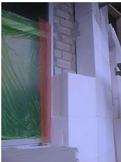
Isolamento termico della parete esterna
