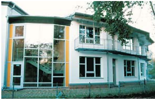
La scuola Waldorf di Brema-Sebaldsbrück
