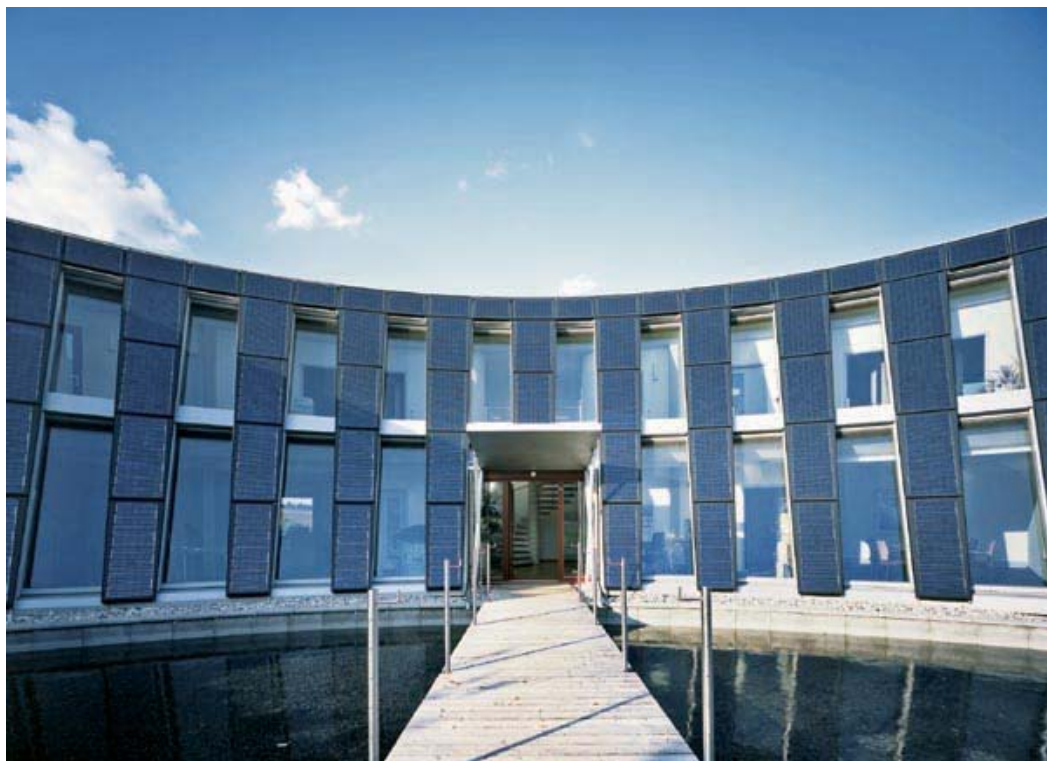
Facciata sud dell'edificio amministrativo
